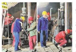
目XB03钻孔套管安装。该钻孔设计孔深682m,最大孔径φ300mm,要求下入φ219mm×8mm的套管,套管总长561m,总重量23吨多。为确保顺利完成下管任务,该公司组织技术人员和现场施工人员研究分析,决定采用溜孔、焊接、泥浆调试、加装浮标
